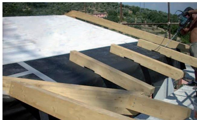
Le membrane traspiranti possono essere fissate direttamente sugli isolanti (non flessibili) mediante graffe, colla o chiodi a testa larga.
