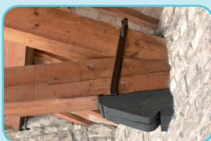
È buona norma presidiare il giunto con una “fasciatura passiva” regolabile. È detta passiva perché entra in funzione solo in caso di scorrimento del puntone. Può essere realizzata con una piastra ad U, su cui sono saldate due barre filettate. La piastra avvolge inferiormente la catena e viene serrata tramite due dadi per mezzo di una contropiastra sul puntone.
