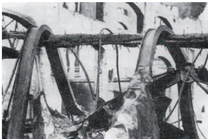
A seguito di un incendio le travi metalliche hanno ceduto piegandosi sugli elementi di legno. Il fuoco ha ridotto le sezioni delle travi in legno, ma queste hanno resistito.
