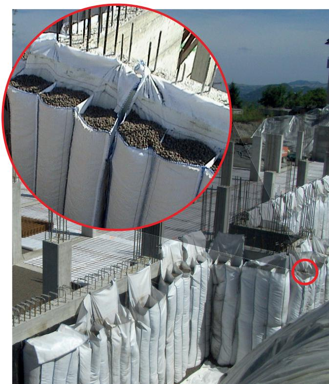
Figura 24 - Isolamento continuo in forma granulare (argilla espansa) sulla porzione di parete (nelle comode "bag" di contenimento). Impermeabilizzare preventivamente la parete controterra.
