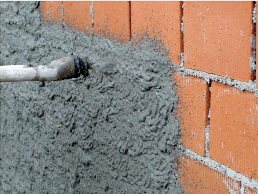
Il termointonaco si impasta con acqua e si stende come un comune intonaco o mediante apposite pompe a spruzzo ponendo attenzione che non si formino fessurazioni.
