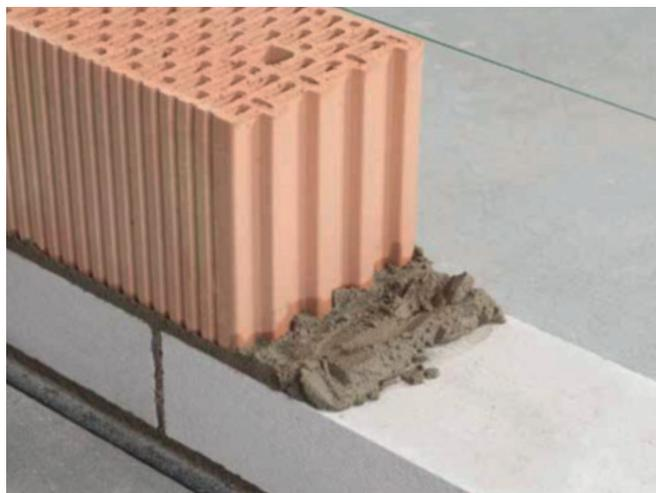
Figura 21 - Taglio termico del primo corso di mattoni realizzato con calcestruzzo cellulare idrofugato in una muratura non portante
