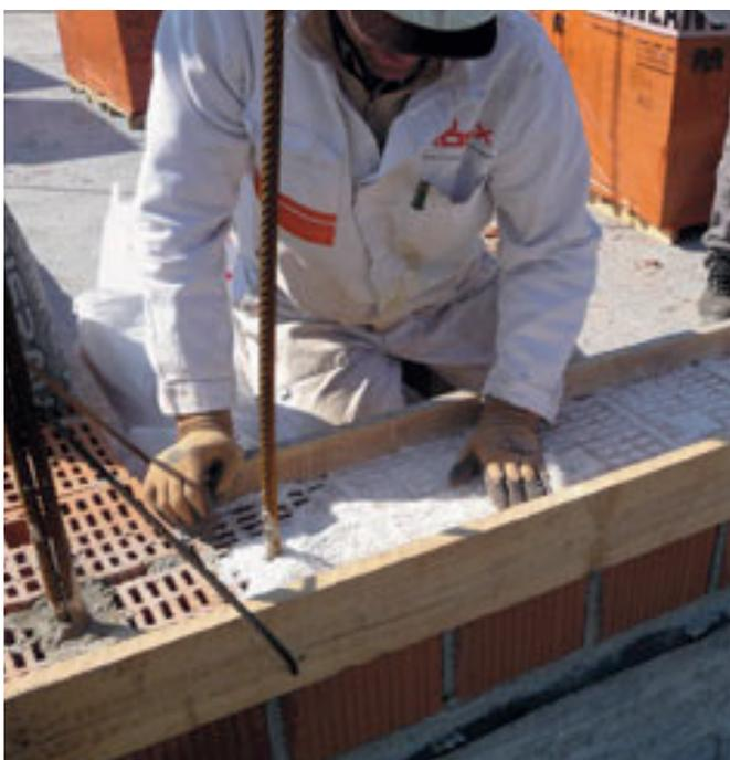
Figura 22 - Fase di riempimento del primo corso della muratura con perlite [fonte Consorzio Poroton]
