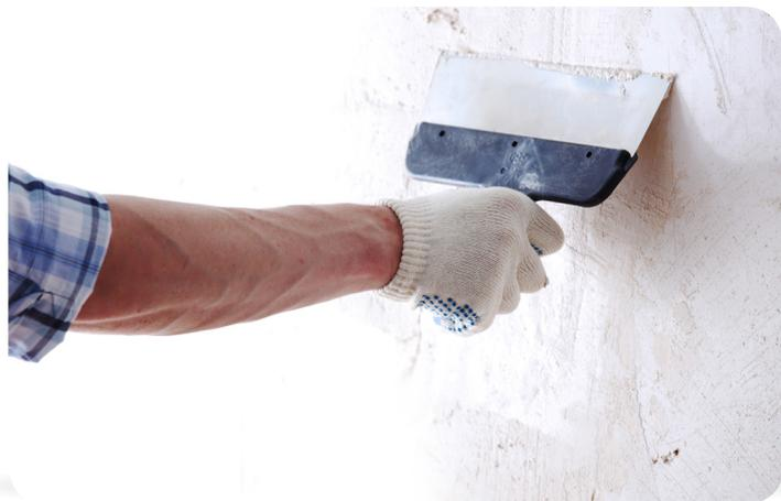
• La preparazione delle pareti da tinteggiare è la fase più importante per ottenere un buon risultato. Se le pareti presentano crepe o fessure, o bolle e sfaldamenti è necessario provvedere ad eliminarle ed uniformare la superficie. Per le stuccature si può utilizzare dello **STUCCO IN PASTA**, già pronto e cremoso, o della scagliola in polvere da impastare con acqua.
