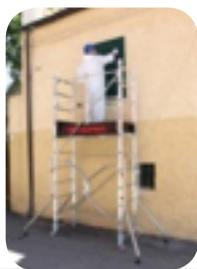
**TRABATTELLO:** in caso di soffitti molto alti o pareti molto grandi può essere utile questo tipo di mini ponteggio, costituito da un'impalcatura realizzata con tubi di ferro e pianali di calpestio generalmente in legno, facilmente movimentabile grazie alle ruote.
