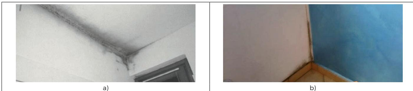
Figura 8 - a) Ponte termico tra parete e solaio di copertura. b) Ponte termico dello spigolo costituito tra le pareti e il pavimento.
