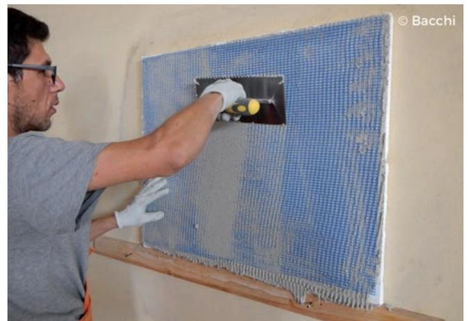
Figura 2 - Pannello in silicato di calcio a basso spessore per isolamento dall'interno con risoluzione dei problemi di muffa
