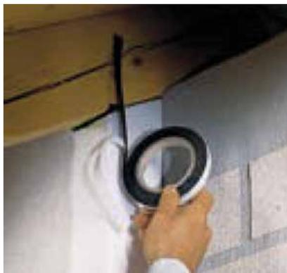
Figura 5 - Corretta posa del nastro precompresso autoespandente tra puntone e isolante
