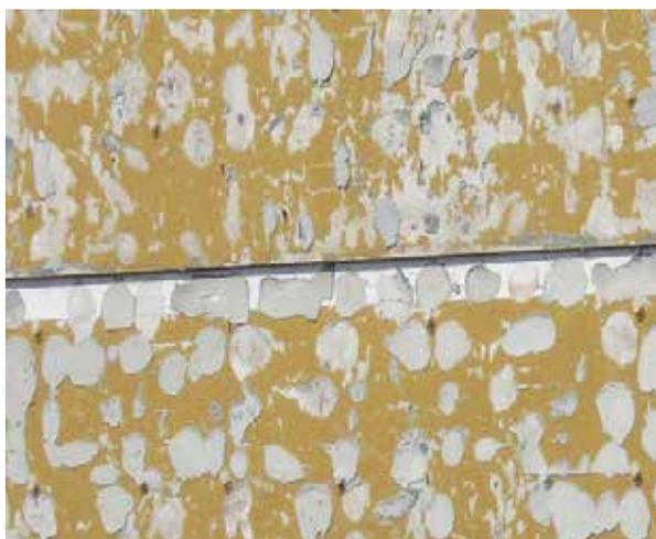
Figura 16 - Distacco di cappotto per posa isolante a punti ed errata configurazione della tassellatura. Inoltre i tasselli non risultano posizionati in corrispondenza dell'adesivo.
