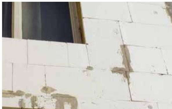
Figura 2 - Pannello isolante non accostato correttamente (a sinistra); errato riempimento dei giunti con malta adesiva/rasante (a destra). Nell'immagine di destra i giunti sfalsati non sono realizzati correttamente.
