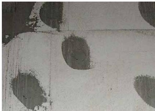
Figura 17 - Tasselli inseriti troppo in profondità e ricoperti con malta cementizia (sopra); alterazione cromatica della facciata (sinistra).
