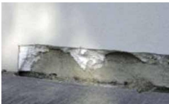
Figura 7 - Mancanza del profilo di partenza e isolante non indicato per la zoccolatura. Qui sotto render della corretta realizzazione della zoccolatura.
