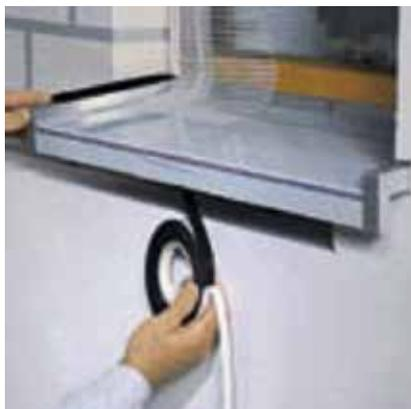
Figura 6 - Posa nastro autoespandente precompresso tra davanzale e isolante
