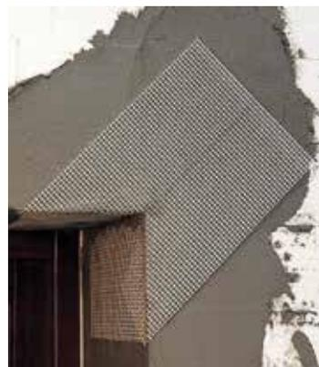
Figura 19 - Fessurazione della rasatura armata per mancanza di rete di rinforzo agli angoli (sopra); qui a fianco un esempio di posa a regola d'arte.
