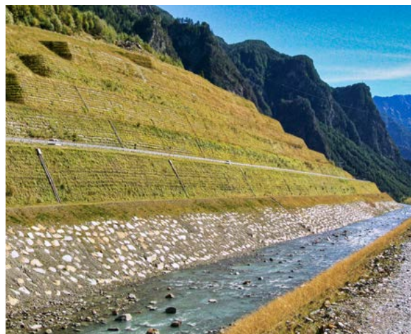
Figura 8 – Realizzazione di rilevati in terra rinforzata (fonte TENAX)
