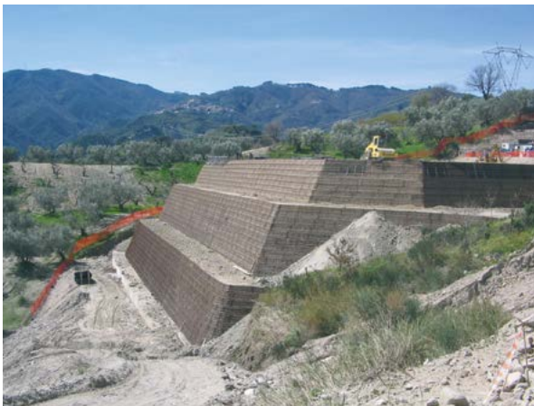
Figura 6 – Realizzazione di terre rinforzate (fonte TENAX)
