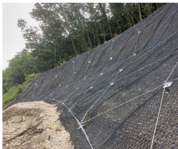
Figura 3 – In un progetto di stabilizzazione, gli interventi geotecnici adottati, al fine di aumentare il fattore di sicurezza al di sopra dei limiti previsti per legge, sono scelti in funzione delle caratteristiche del modello fisico-evolutivo del dissesto reale o ipotetico e in relazione ai fattori predisponenti il dissesto stesso. In questo caso occorre assicurare una coltre detritica di versante, oggetto di dilavamento in occasione di eventi meteorici importanti (fonte TeMa).
