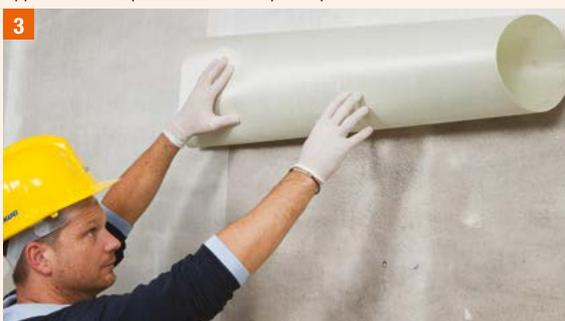
Applicazione di MapeWrap EQ Net (risolto in orizzontale e sovrapposizioni laterali di almeno 10 cm)
