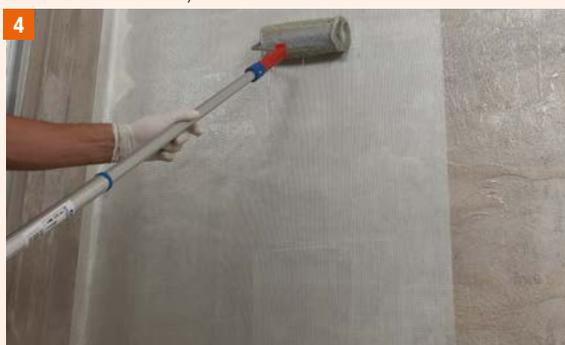
Applicazione del secondo strato di MapeWrap EQ Adhesive
