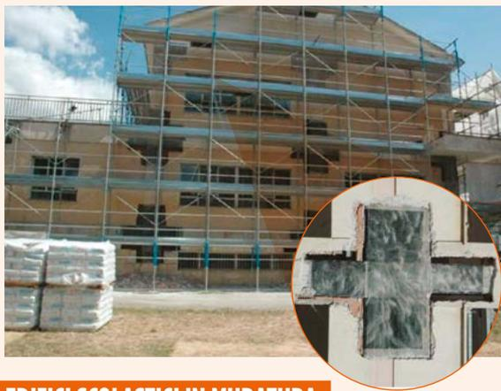
2. incremento della resistenza a taglio del pannello di nodo con doppio strato di tessuto quadriassiale in fibra di carbonio **MapeWrap C QUADRI-AX**;
