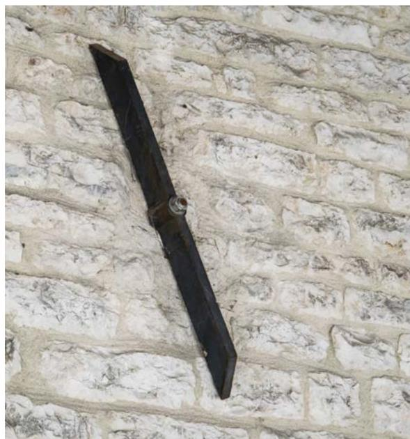
Tirante metallico e piastra di ancoraggio sulla facciata di un vecchio edificio in muratura
