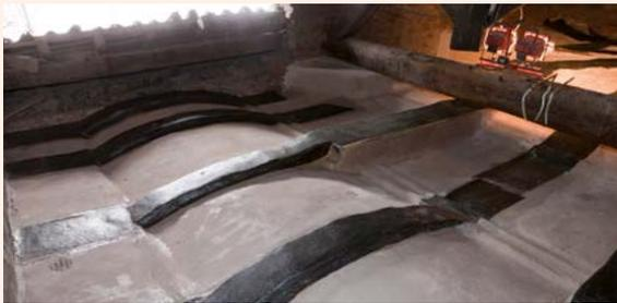
b) Altra soluzione è l'applicazione di **MasterEmaco S 286 FR di Basf**; si tratta di una malta da muratura, di calce pozzolanica, priva di cemento, confezionata con aggregati silicei naturali aventi diametro massimo 2 mm e rinforzata con fibre polimeriche spruzzabili e ad altissima tenacità. La sua applicazione garantisce una resistenza a compressione superiore ai 15 N/mm<sup>2</sup>, pertanto è classificata con la sigla M15 ai sensi della normativa europea UNI EN 998/2.
