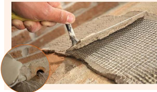
basalto e acciaio **GeoSteel Grid 200** o in fibra di vetro **Rinforzo ARV 100** sempre installate mediante malta di calce idraulica naturale **GeoCalce F Antisismico**, garantendo la traspirabilità e la compatibilità dell'intervento.
