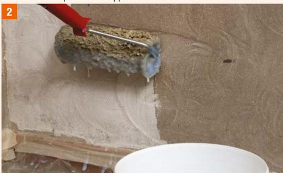
Applicazione del primo strato di MapeWrap EQ Adhesive
