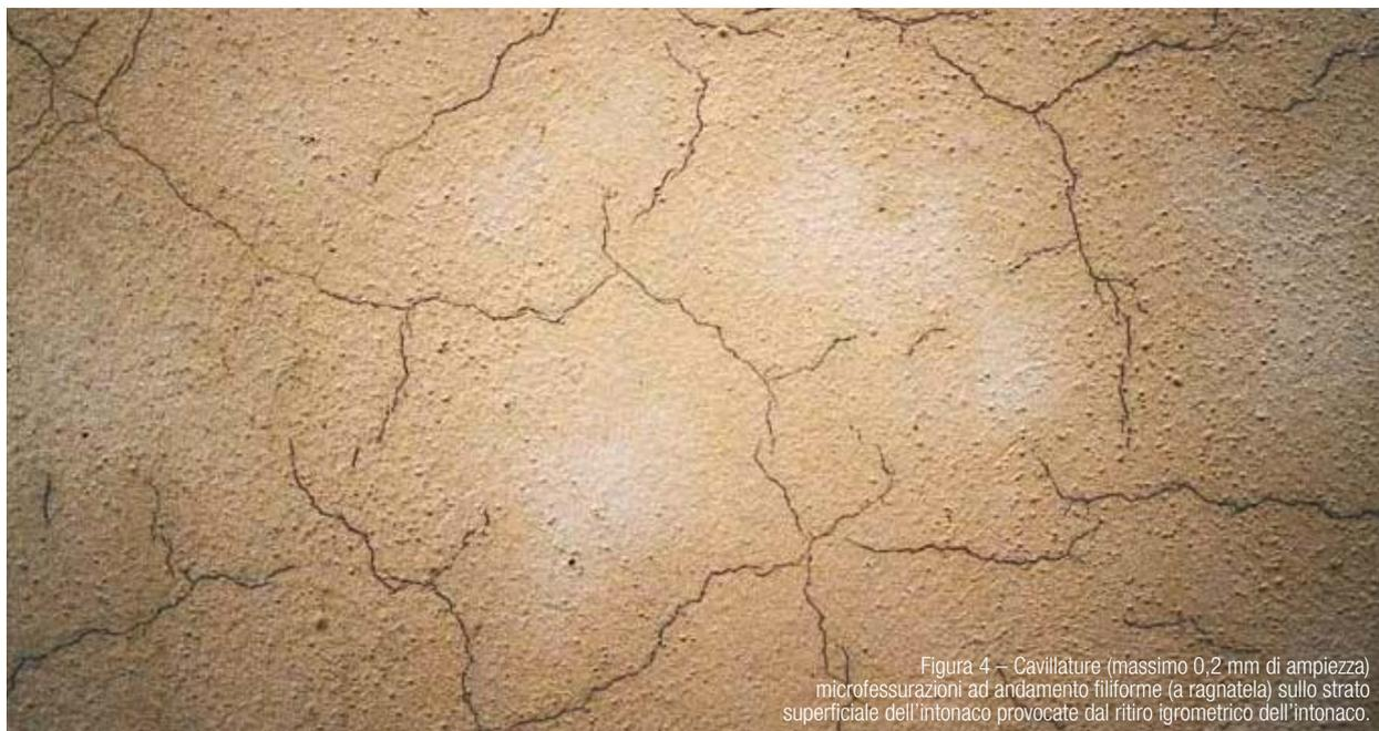
Figura 4 – Cavillature (massimo 0,2 mm di ampiezza) microfessurazioni ad andamento filiforme (a ragnatela) sullo strato superficiale dell'intonaco provocate dal ritiro igrometrico dell'intonaco.
