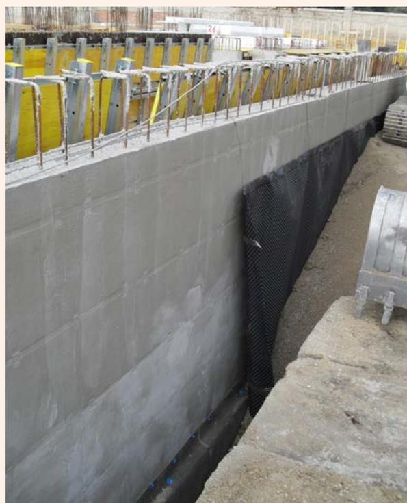
**Il vantaggio dei teli bentonitici è di poter essere usati in condizione non solo di pre-getto poiché caratterizzati da un comportamento autoaggrappante al calcestruzzo e autosigillante con la saldatura delle sovrapposizioni a garanzia della continuità di tenuta all'acqua, ma anche di post-getto fissando meccanicamente il telo alla struttura già realizzata.**
