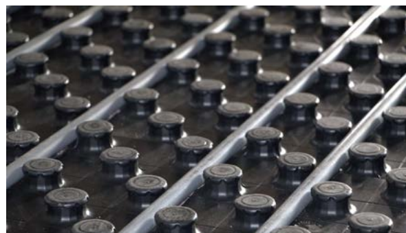
Figura 16 – Particolare di un sistema di riscaldamento a pavimento, con una fitta serpentina di sottili tubicini flessibili tenuti in posizione da pannelli isolanti con apposite protuberanze
