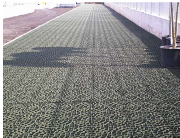
Figura 18 – Esempio di armatura per prato armato, carrabile o pedonale
