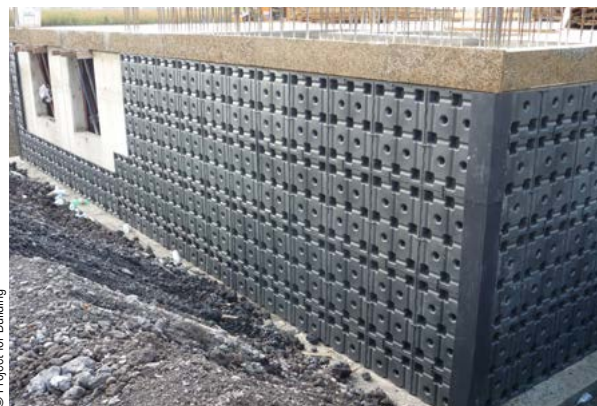
Figura 11 – Pannelli modulari in polipropilene per l'impermeabilizzazione dei muri controterra e delle porzioni interrate di un edificio
