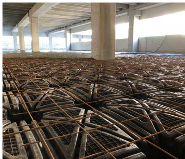
Figura 8 – Posa della rete elettrosaldata di armatura per la formazione del solaio controterra di un edificio con casceforme a perdere per intercapedini areate
