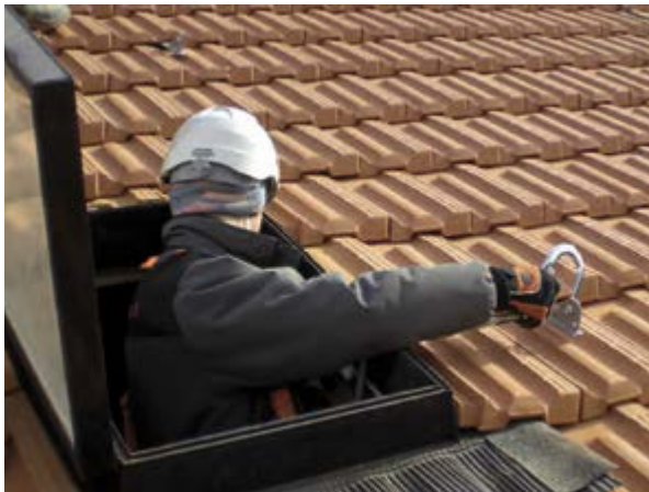
Figura 5 – Accesso alla copertura: in prossimità del punto di accesso deve essere sempre presente un punto di ancoraggio conforme alla norma EN 795 di classe A1 o A2 (nella foto è un ancoraggio sottotegola di classe A2)
