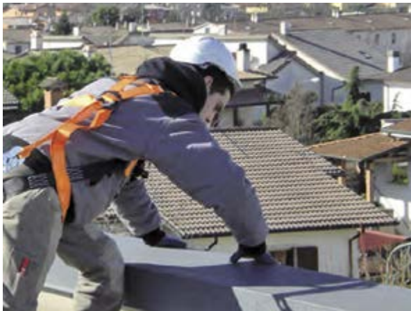
Figura 2 - Esempio di fattore umano: insorgenza di vertigini lavorando in prossimità del bordo della copertura
